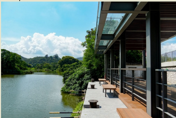
河套區發展附近的惇裕渡頭小型活化改善工程 (進行中)
