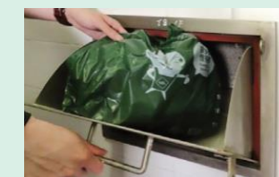
樓層垃圾槽口
